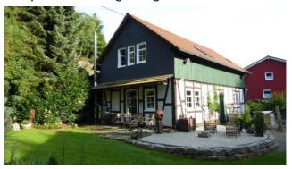
Das Klima im Lehmziegel-Haus ist gleichbleibend angenehm, im Sommer kühl und im Winter warm. In die Wände wurde eine Art "Fußbodenheizung" installiert, die die Wärme ins Innere der Räume abgibt.
